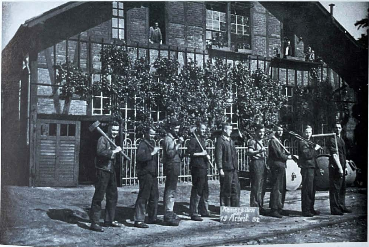
Die alte Lehrwerkstatt — an dieser Stelle befindet sich heute das Gebäude 20.
